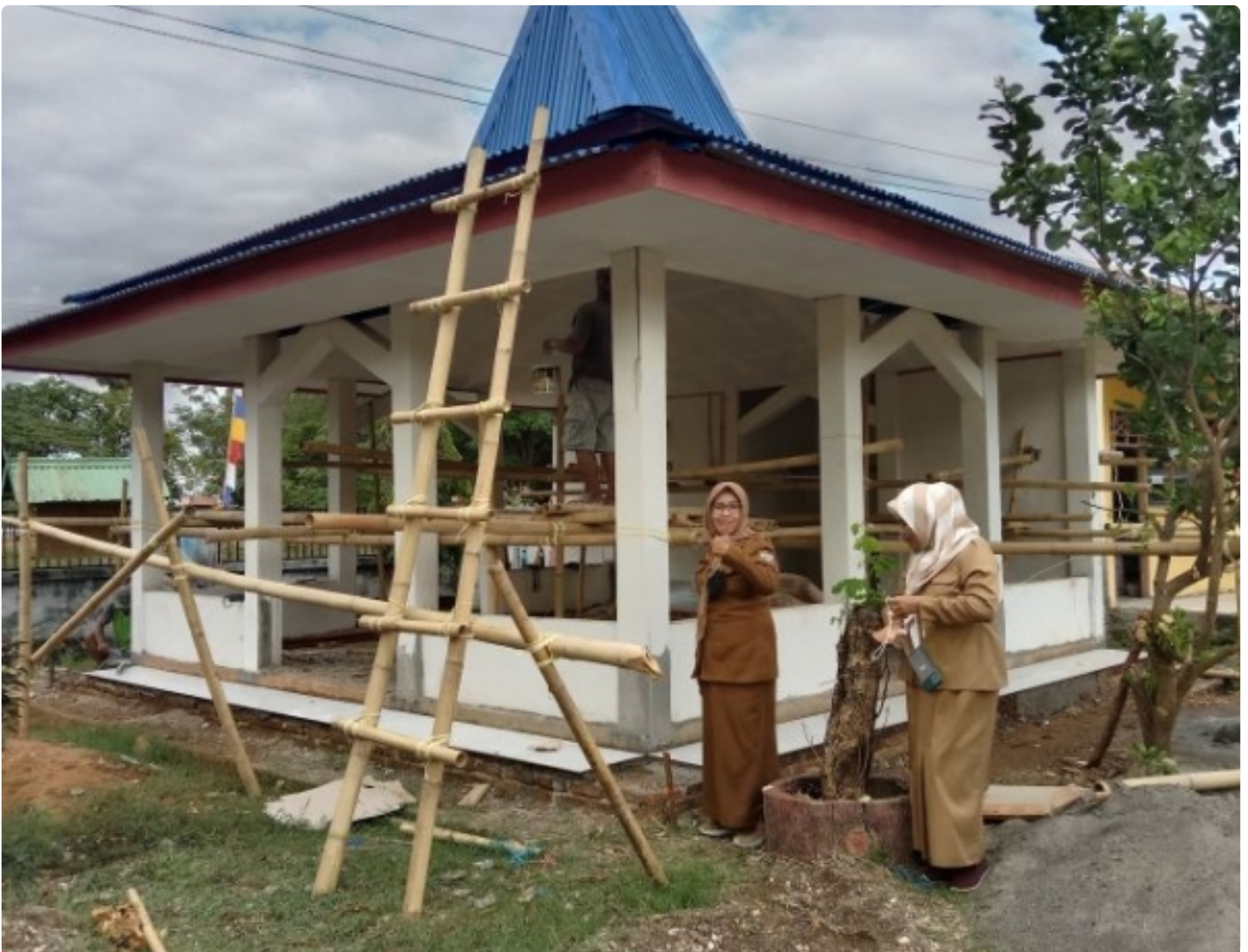
Kepsek SDN 1 Kassi pantau pembangunan musholla
